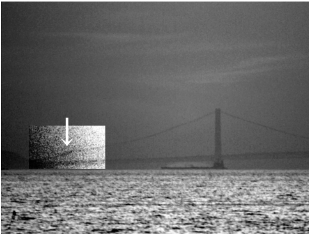
写真4. 明石海峡大橋のケーブル(一部コントラスト調整)
