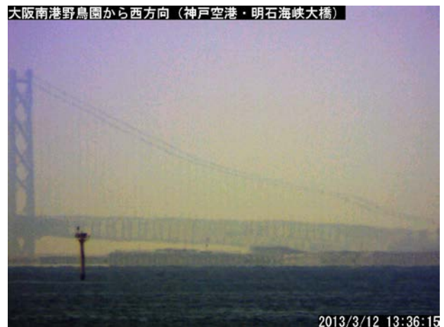
写真4. 明石海峡大橋の橋桁が上下に伸びて 非常に太く見えている
