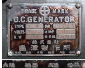
発電機の銘板
