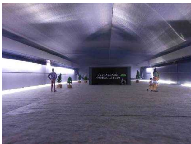
写真29. 天井用光源がつかない状態
