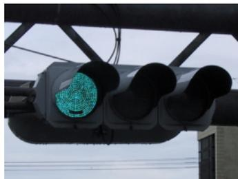
写真2. LEDを用いた信号機
