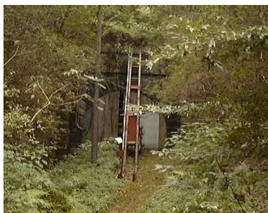
図 2. 三石のトンネルの入り口
